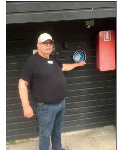
Flydesparren, der skal bruges ved olieudslip, befinder sig i dette PVC-rør, bygget ind i huset ved benzintanken i Indelukket.
