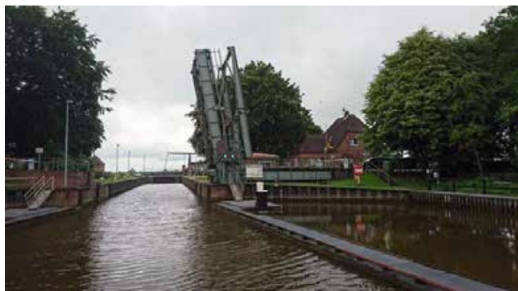
Gislauslusen, med kig mod Kielerkanalen.
