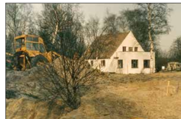
Arbejdet med anlæggelse af bådpladser blev straks begyndt. Foto fra 1970
